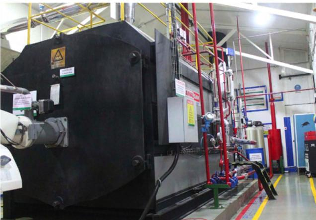
Reemplazo de chip de madera por gas natural
